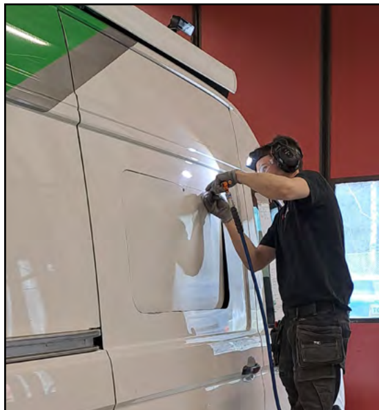
Tässä tehdään reikää tulevalle ikkunalle.
